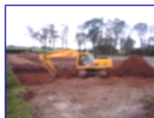
Travaux de BTVOS Mai 2009
